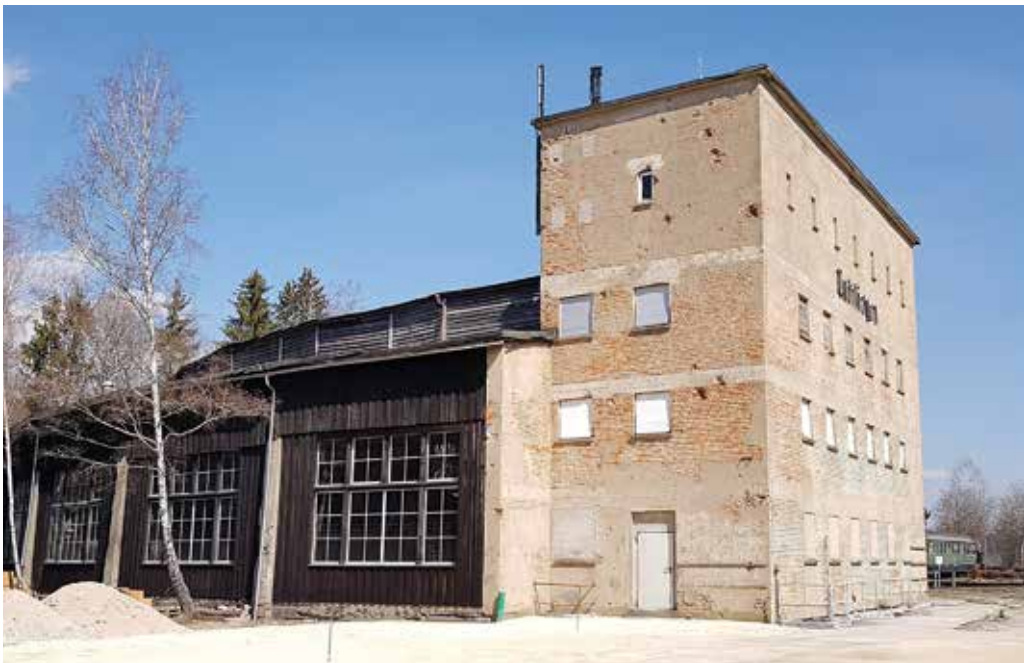
Verwaltungsgebäude während der Restaurierung © Deutsches Dampflo- und Modelleisenbahnmuseum
