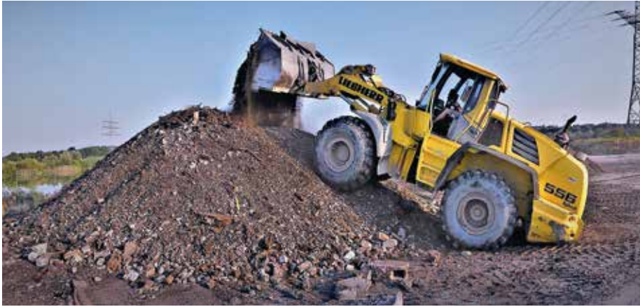
Bagger mit Aushub © privat
